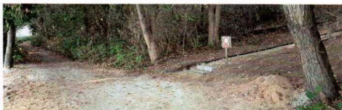
Widok budowanego zejścia łączącego się ze ścieżką przy jeziorze
