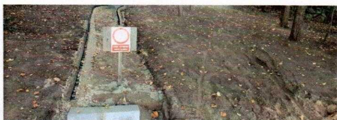
Budowane schody ze znakiem „ TEREN PRYWATNY – ZAKAZ WJAZDU ”
