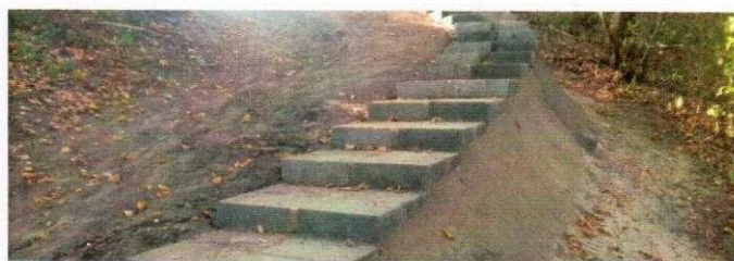
Betonowa skarpa o znacznej wysokości (po prawej stronie)
